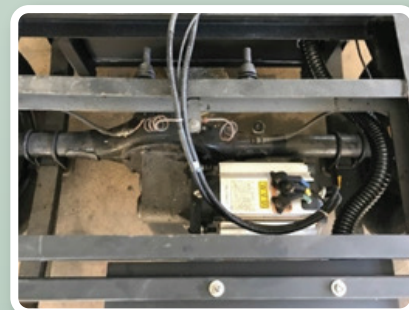
ติดตั้งชุดมอเตอร์เฟืองท้าย
