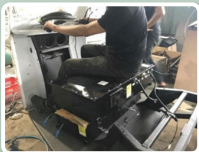
ติดตั้งแบบเตอร์ี่ก่อนที่สอง
