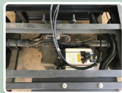
ติดตั้งชุดมอเตอร์เฟืองท้าย
